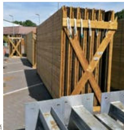
Le mur acoustique est réalisé en bois de pin. Ce même type de mur est utilisé le long des voiries pour atténuer le bruit des voitures.
